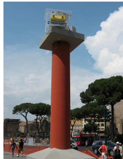
Figure 7. The concrete tower for the interferometric monitoring of the Basilica di Massenzio (Via dei Fori Imperiali, Rome).
