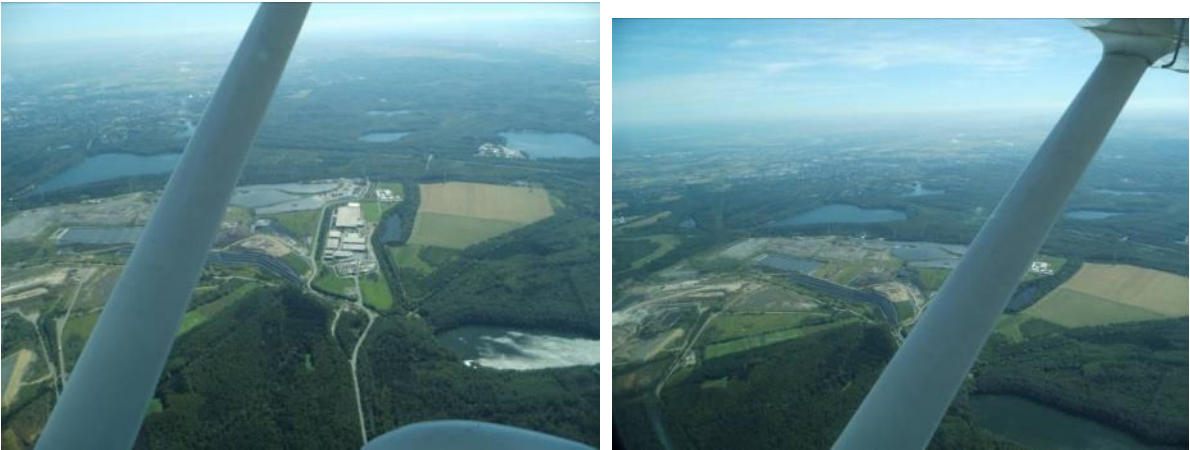
Figure 17: Situation over the Vereinigte Ville landfill.
